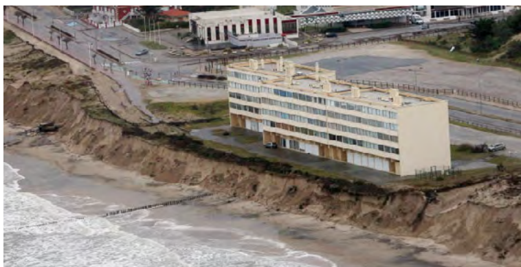
Figure 6 : Immeuble le Signal - Gironde (crédits : Laurent Theillet/Photopqr/Sud Ouest/Maxppp)
